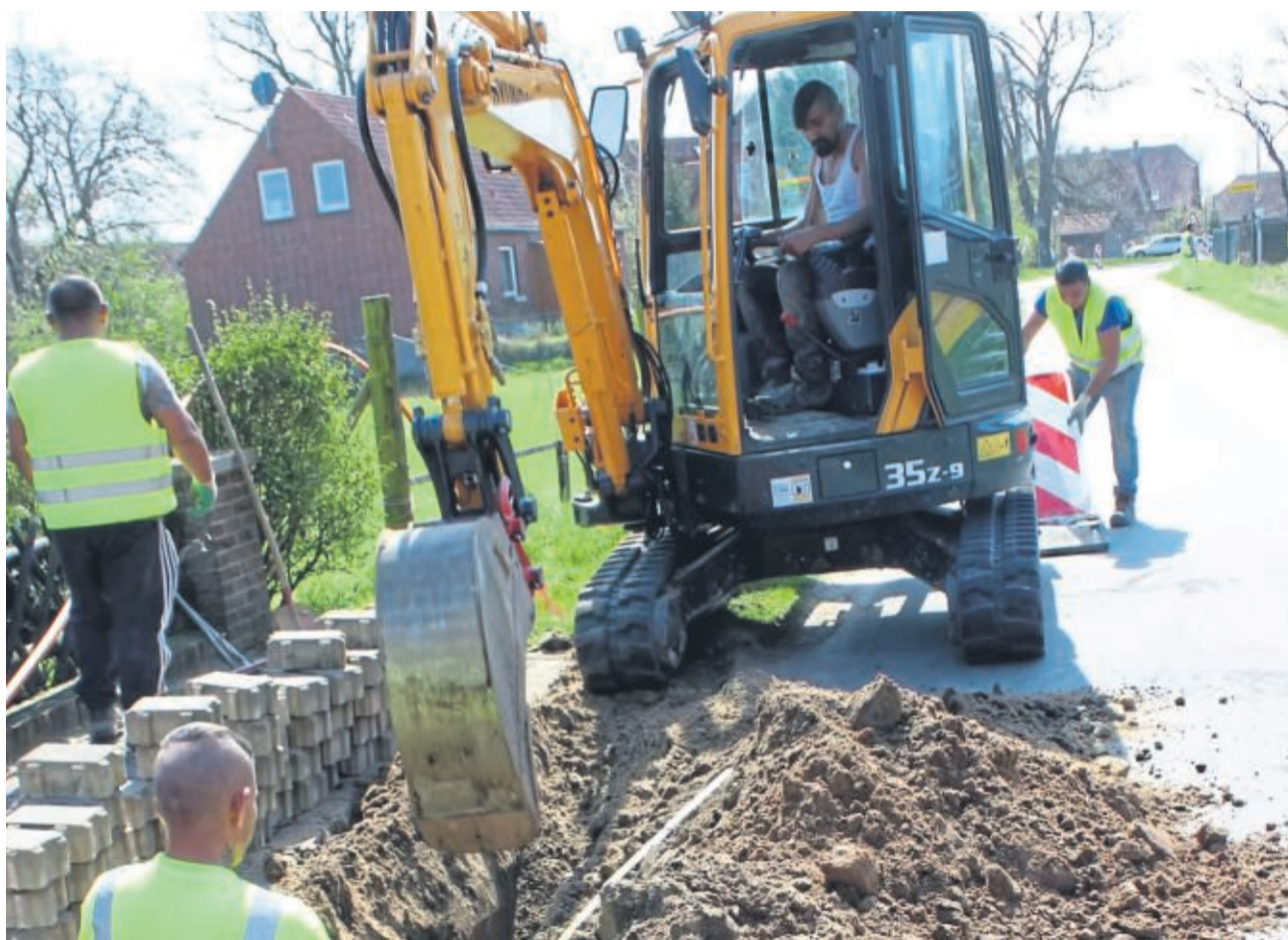
Die Arbeiten am Glasfasernetz laufen nach wie vor im Landkreis. Insgesamt 1400 Kilometer Glasfaser werden in der Region verbaut.
